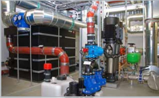
Löschwasser-Übergabestelle gemäß DIN 14462 mit Grundfos-Komponenten Vorlagebehälter, Druckerhöhungsanlage und Hebeanlage
