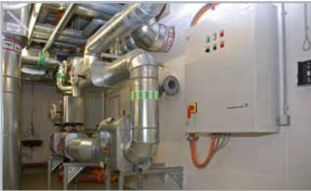
Separate Steuerung der redundanten Löschwasser-DEA-Pumpen über die spezielle Steuerungseinheit Control Fire CRF gemäß DIN 14462
