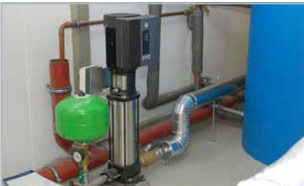
Versorgung von Nichttrinkwasser-Verbrauchern über eine hocheffiziente, drehzahlregelte Einzelpumpenanlage Grundfos Hydromono CRE 5-16
